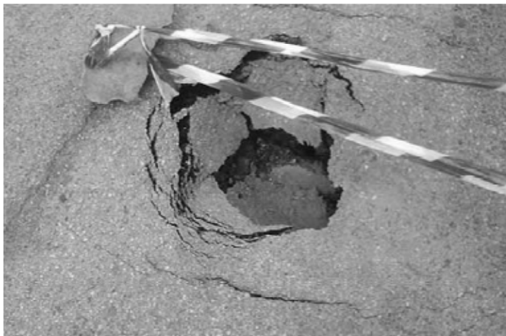
Esempio di cedimento della pavimentazione stradale a causa di una errata valutazione della sua capacità portante
